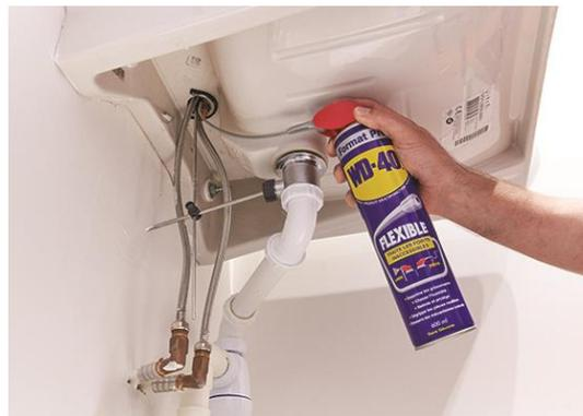
*Dégripper une vis ou un écrou sous évier.*
